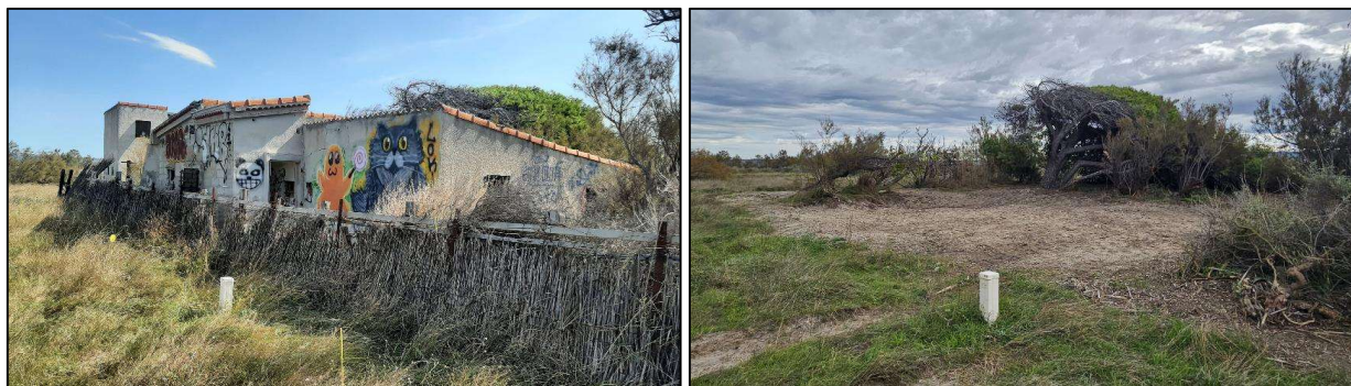
Figure 7 : Chantier de démantèlement de deux anciennes habitations amiantées.
